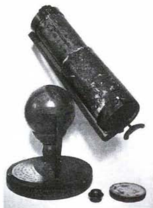
Slika 1. Prvi reflektor, ki ga je izdelal Newton leta 1668. Povečava tega teleskopa je bila menda okoli 25-kratna.
